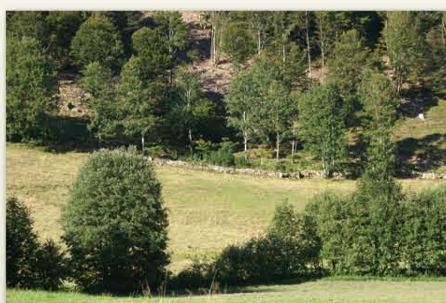
Auf einer Länge von etwa zwei Kilometern wurden die Trockenmauern saniert.
