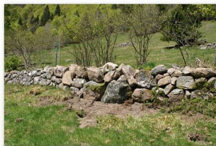
Saniertes Teilstück einer Trockenmauer.
