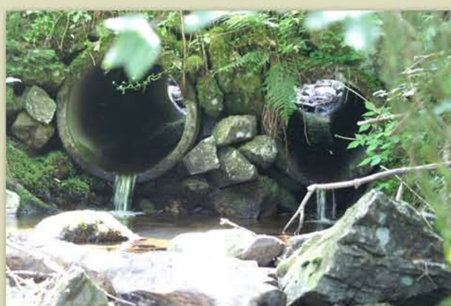
Dolen in Waldwegen unterbrechen die Durchgängigkeit des Baches und sind Wanderhindernisse für Fische und Kleinlebewesen.
