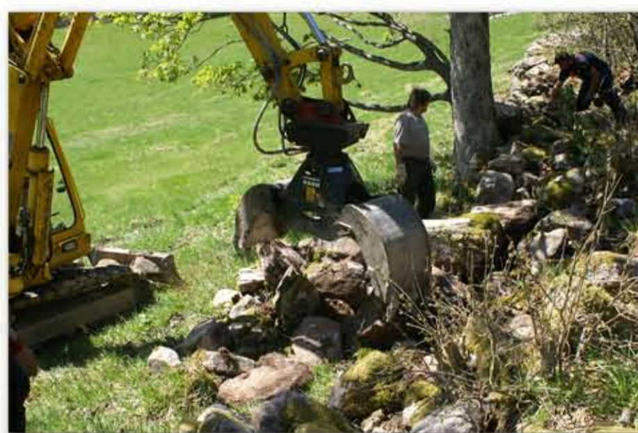
An Mauerstellen, die durch das Holzschleifen beschädigt waren, wurden die Steine aufgenommen und die Mauer instand gesetzt.
