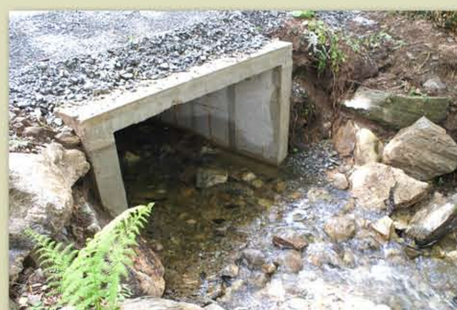
Die Durchgängigkeit wurde durch ein Brückenprofil mit natürlicher Bachsohle wieder hergestellt. (Krunkelbach, Schleifbach)
