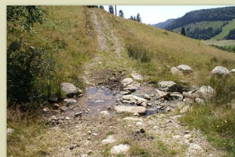
Am Farnwittebach wurde eine Furt durch den Fahrweg gebaut: Der Bach fließt offen über größere Steine, die bei Bedarf überfahren werden können.
