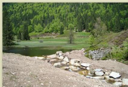
Eine Pendelrampe garantiert heute die Durchgängigkeit des Gewässers. Durch die Erhöhung und Sanierung des Damms wird die Klusenmauer nicht mehr hinterspült und sie konnte als historisches Dokument erhalten werden. (2010)
