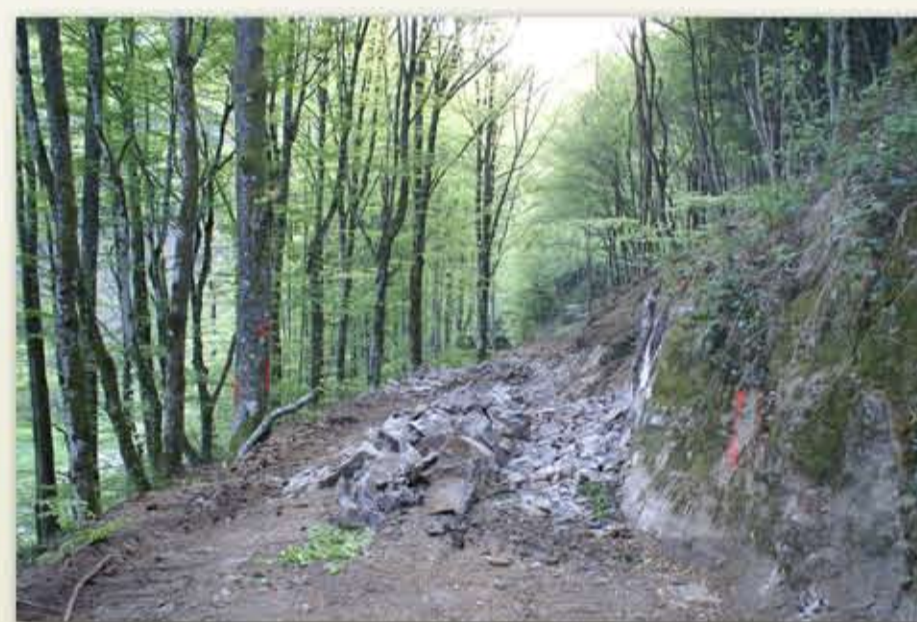
Beim Wegebau mussten Felsen abgespitzt werden. (2007)
