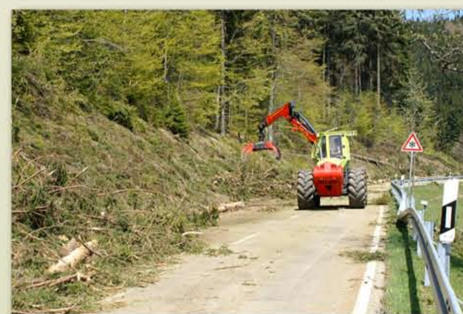
Fichten werden abtransportiert. (2006)
