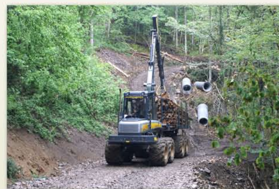
Auf dem neuen Maschinenweg können Holz und Dolen transportiert werden.
