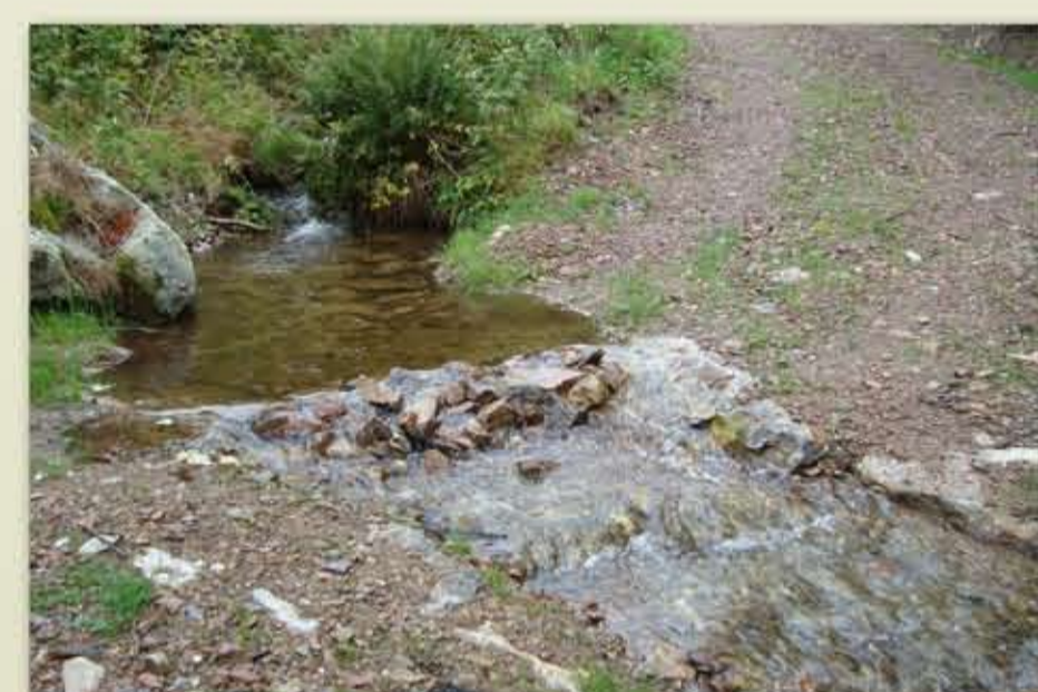
Um die Flächen im Nesslergrund mit dem Schlepper erreichen zu können, mußte der Fahrweg saniert werden. Der Bach quert den Weg über eine Furt, die Dole wurde entfernt. (2009)
