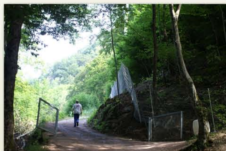
Wenn Ziegen auf steinigen Hängen laufen, gibt es Steinschlag. Daher musste zum Schutz der Häuser am Fuß der Utzenfluh ein Geröllschutzzäun installiert werden.
